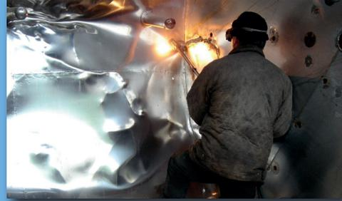
La función principal es utilizar un equipo de oxicorte para realizar el corte o separación en varios trozos de piezas de gran tamaño que por sus dimensiones no pueden ser recicladas. Para la realización del trabajo se dispone de equipo de protección contra radiaciones, proyecciones y gases tóxicos provenientes del material cortado.
