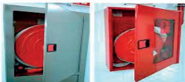
Figura 2 de la NTP 1035: Bocas de incendio equipadas (BIE): utilización.<sup>5</sup>
